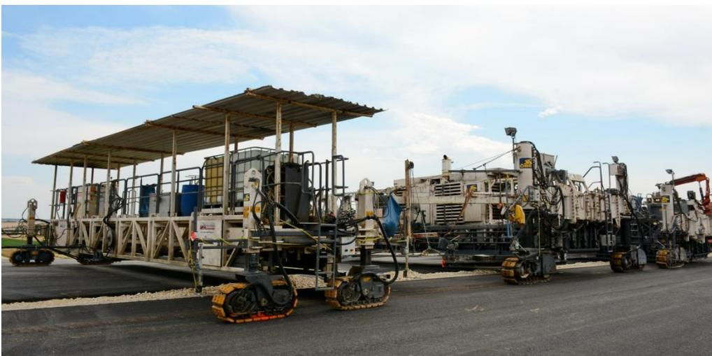
*Die Betondecke der Fahrbahn und die Verschleißschicht wurden in einem Arbeitsgang in einer Stärke von 22 cm aufgetragen.*
